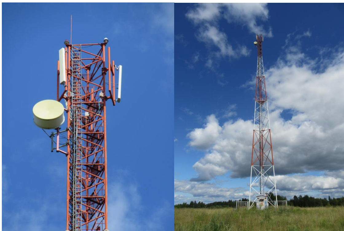
Рисунок 1.4 – Расположение РРС и внешний вид башни высотой 70м (объект-аналог).
